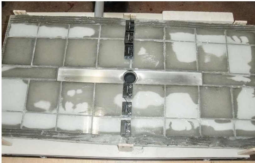
Abbildung 6: Ein Blick durch die Fliesen nach Ende der „Flutung“, zu Beginn der Trocknung: Deutlich sichtbar ist das eingedrungene Wasser im Fliesenmörtel, das sich diffus und willkürlich verteilt hat.
